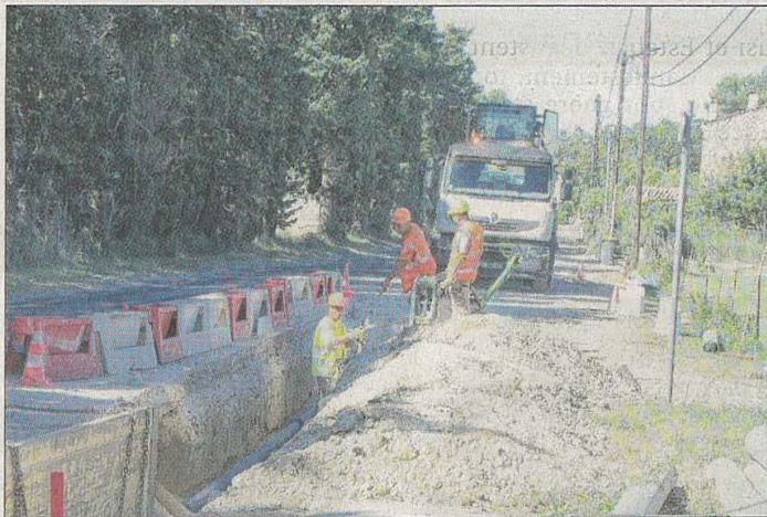
Les travaux sont en cours route d'Aubignan avant de bifurquer sur l'ancien chemin d'Aubignan.
