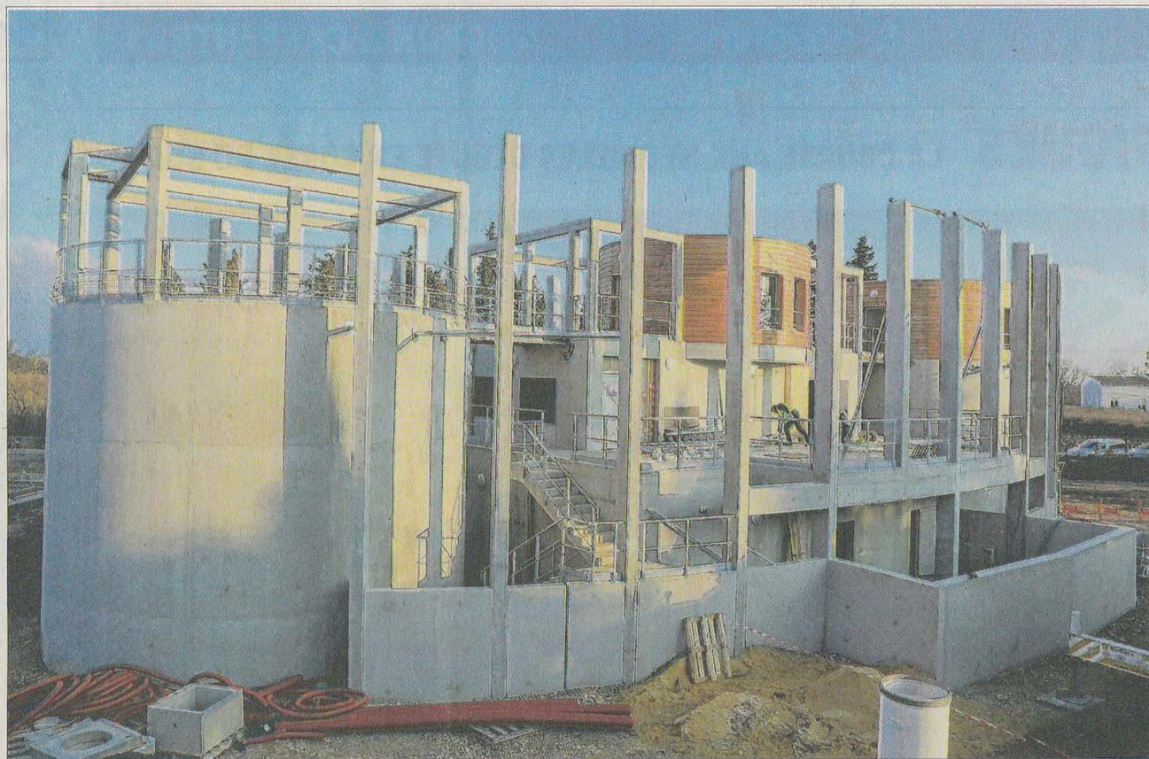
Plus moderne et plus sûre, la nouvelle usine de production d'eau potable de la Jouve est en cours d'achèvement après 20 mois de travaux. Ci-contre, Germain Vayson, responsable maintenance du site, et Julien Nialon, directeur de l'agence Suez Vaucluse. Photos Le DL/Patrick ROUX
