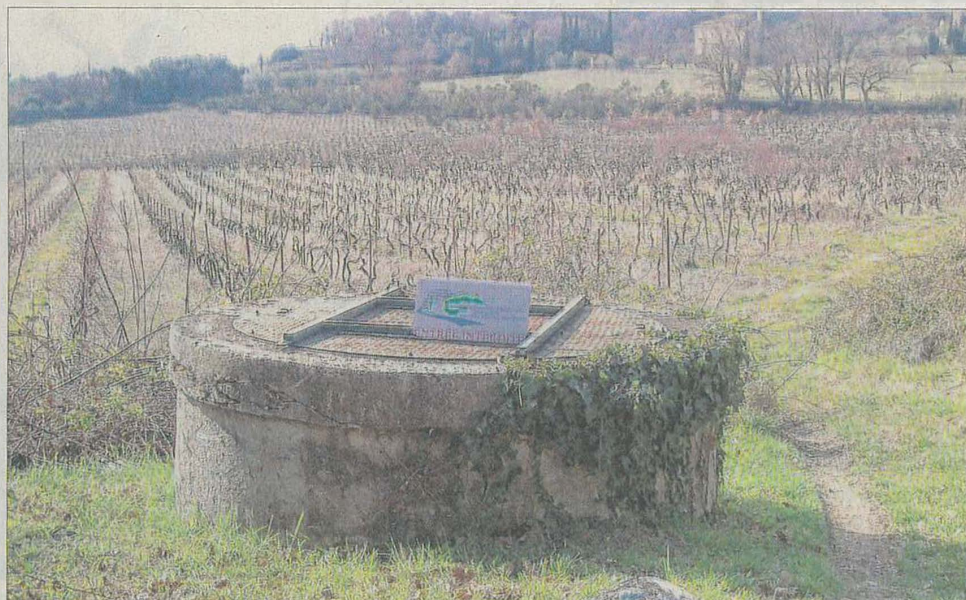
Champ et puits de forage sont protégés.
