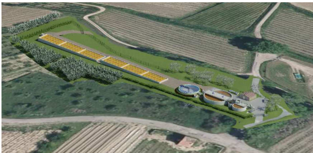
Vue paysagère de la Station d'Épuration
