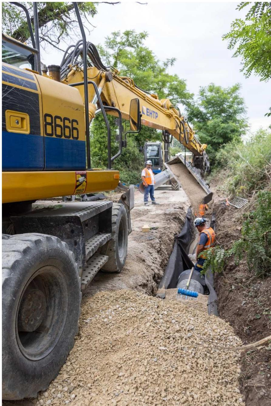
*Photo 10 : Préparation de la pose d'un nouveau tuyau avec la mise en place d'un géotextile et d'un lit de pose en grain de riz*
