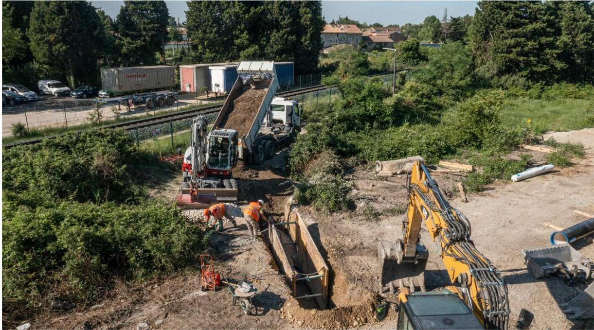
*Photo 6 : Sécurisation pour la stabilité de la tranchée avec la mise en place d'un blindage jointif*
