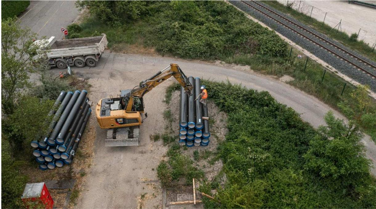
*Photo 2 : vue au drone du bardage soigné de tuyaux par l'entreprise Colas.*
