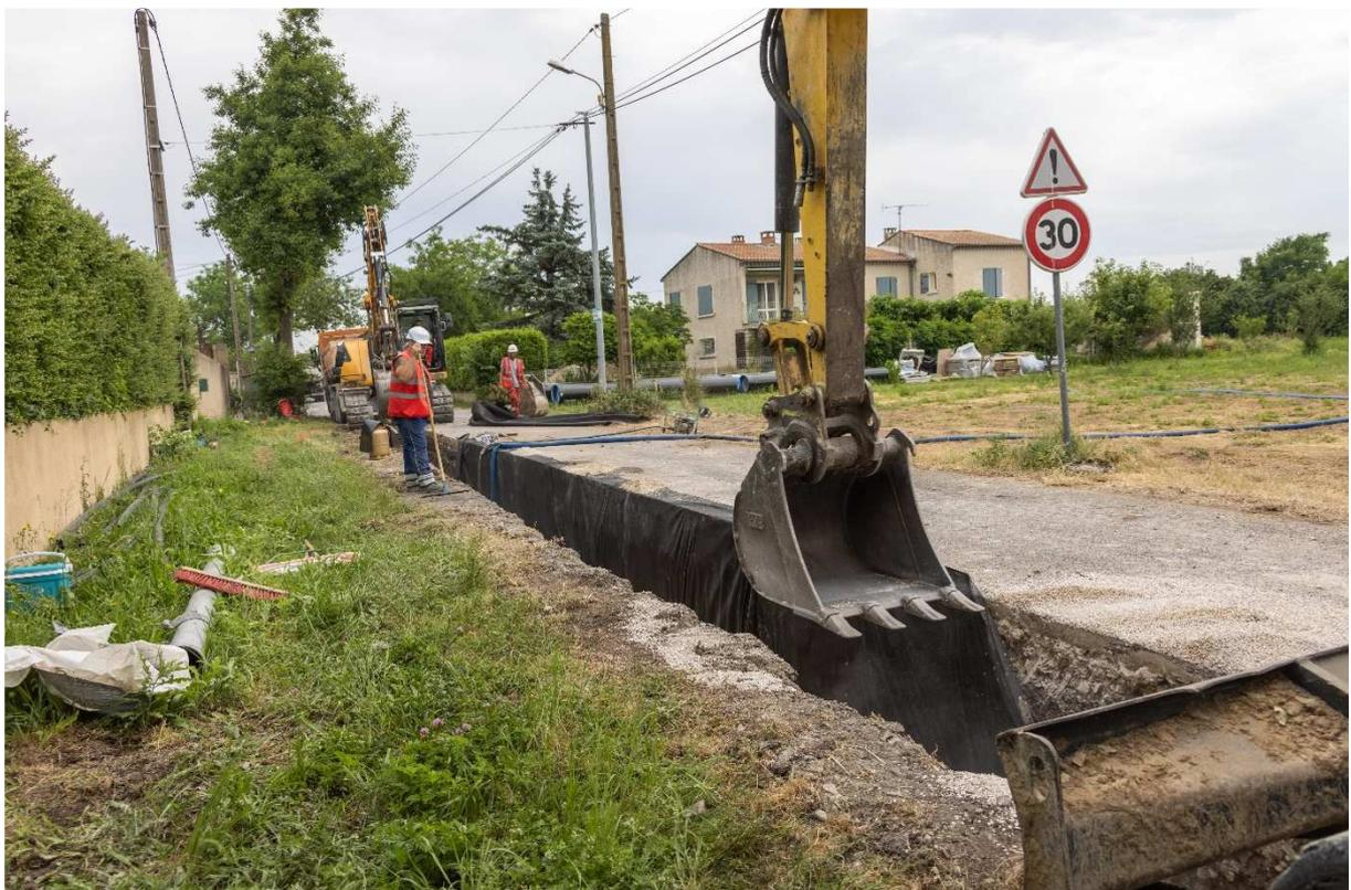
*Photo 12 : Terrassement, pose du géotextile et pompage pour rabattre la nappe par l'entreprise Rampa .*
