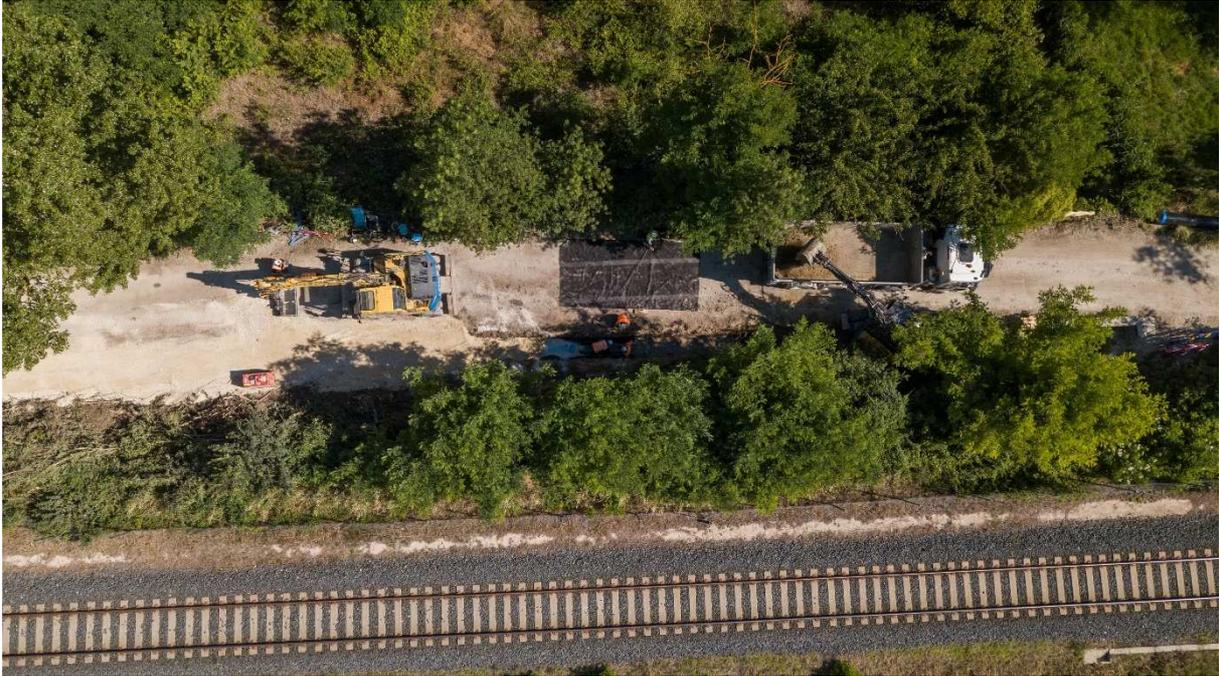
*Photo 8 : vue au drone de la pose de tuyaux par l'entreprise EHTP avec préparation du géotextile. Les nouveaux réseaux sont mis sous le domaine public pour en faciliter l'accessibilité et l'exploitation*
