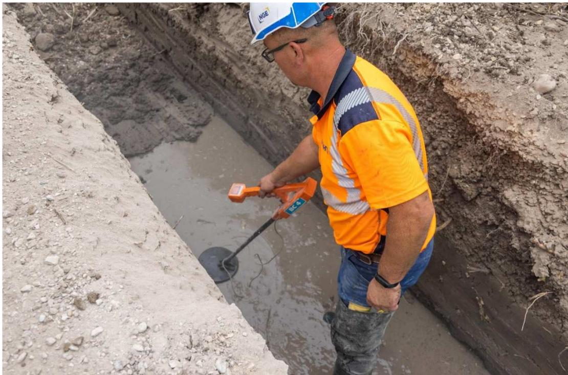
*Photo 7 : Utilisation du détecteur de métaux en fond de tranchée pour rechercher une conduite existante par l'entreprise EHTP.*
