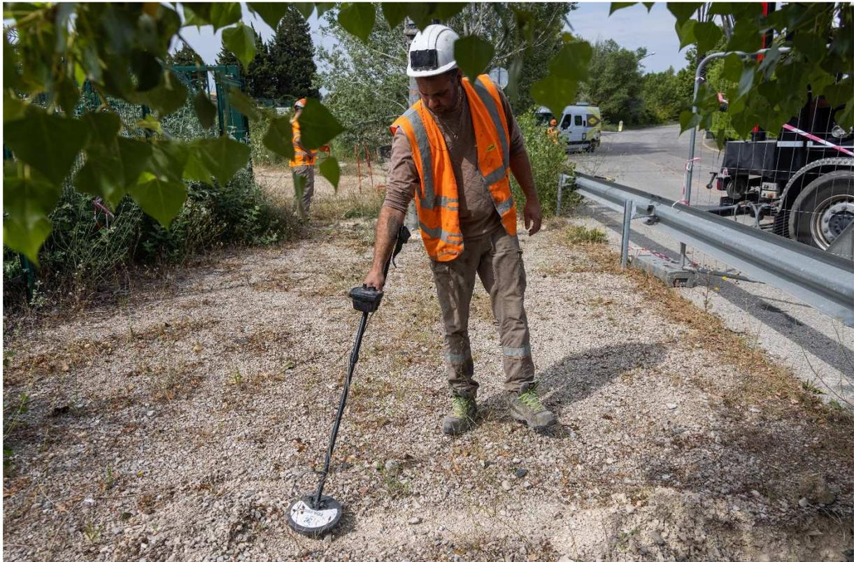
*Photo 4 : recherche d'une canalisation au détecteur de métaux avant l'utilisation de l'aspiratrice.*
