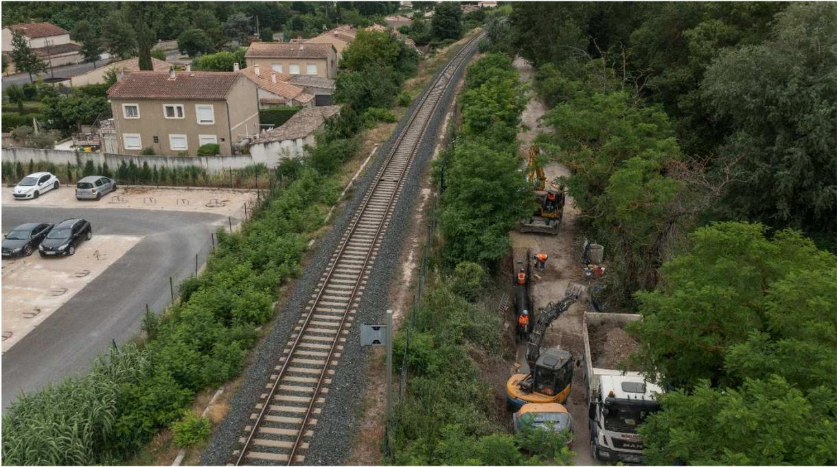
*photo 9 : vue au drone de la pose de tuyaux par EHTP (terrassement).*
