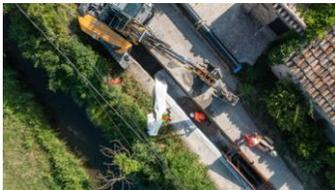
Réhabilitation de 7025 ml de canalisation d'eau potable allant du diamètre 53/63 mm à 500 mm et reprise de 114 branchements.
