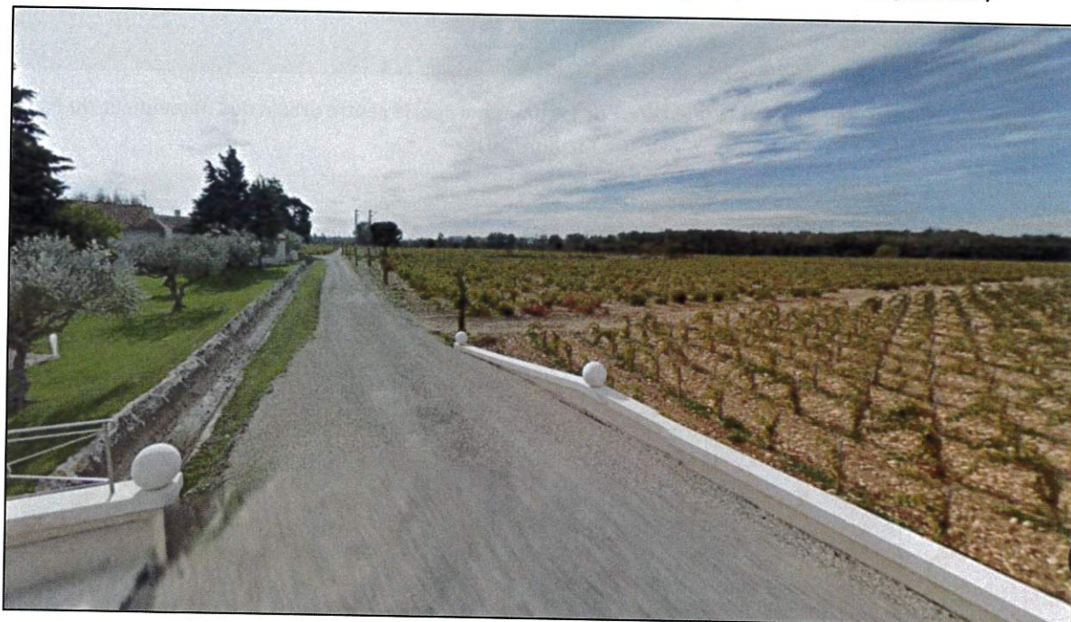
Figure 35 : Vue lointaine sur la zone de travaux de l'ouvrage stockant en amont de la STEP (octobre 2018)
