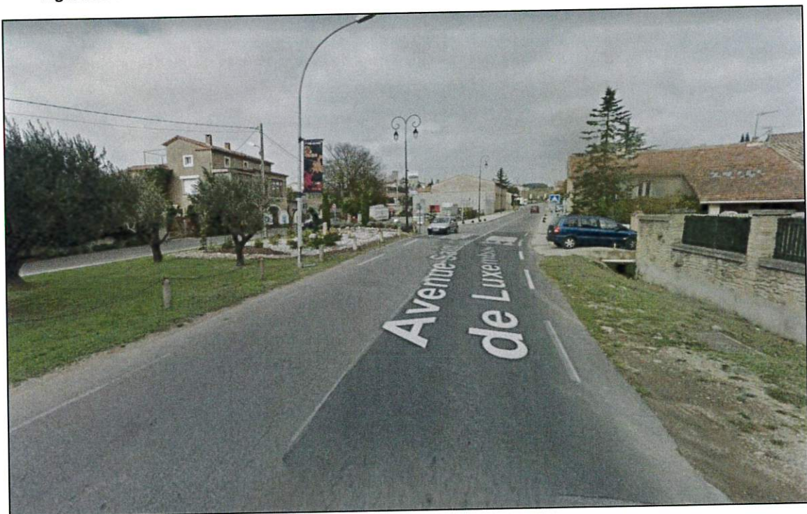
Figure 33 : Vue lointaine depuis le Sud sur la zone de travaux du déversoir d'Orage (Octobre 2018)
