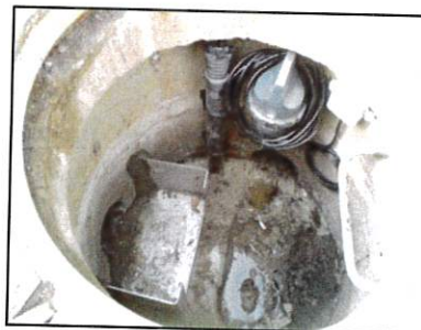
Figure 7 : Déversoir d'orage actuel
