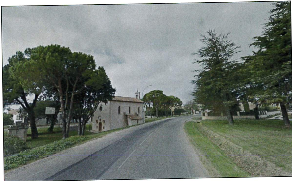
Figure 32 : Vue sur le clocheton au Sud de la zone de travaux du déversoir d'orage (Octobre 2018)
