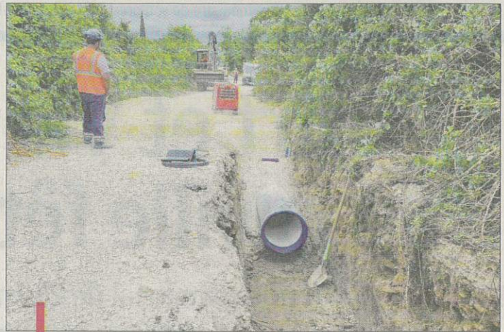
Une nouvelle canalisation, majeure pour le fonctionnement des réseaux, est en cours de mise en place.
