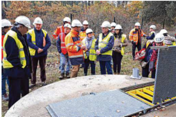
Les participants ont visité les installations de pompage aux Sablons de Mormoiron. / PHOTO G.B.
