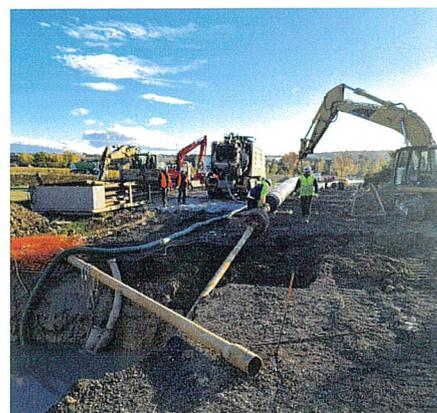
le passage jusqu'à obtenir le diamètre voulu. Il est ensuite possible d'installer la canalisation en PEHD sous l'Ouvèze. Il s'agit de barres de 12 m de long et de 400 mm de diamètre qui sont soudées entre elles jusqu'à atteindre une taille de 250 m de canalisations. Elles sont ensuite tirées dans la galerie grâce à une machine située de l'autre côté de la rive.
