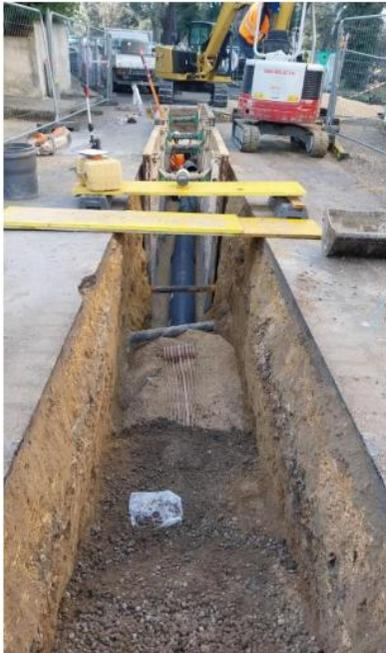
Renouvellement du réseau de collecte structurant en DN 400mm reliant le bas de l'avenue JH Fabre au bas de l'avenue MT Chalon est fortement dégradé et s'effondre par endroit.
