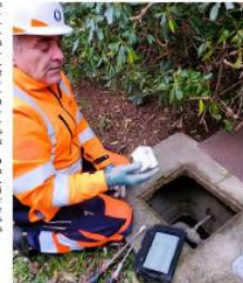
L'installation des compteurs communicants s'effectue en quelques minutes, sans interruption de la distribution d'eau. Photo : S. Ch.
